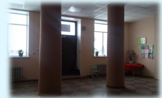
Дом культуры в с. Раздольном ремонт фойе
