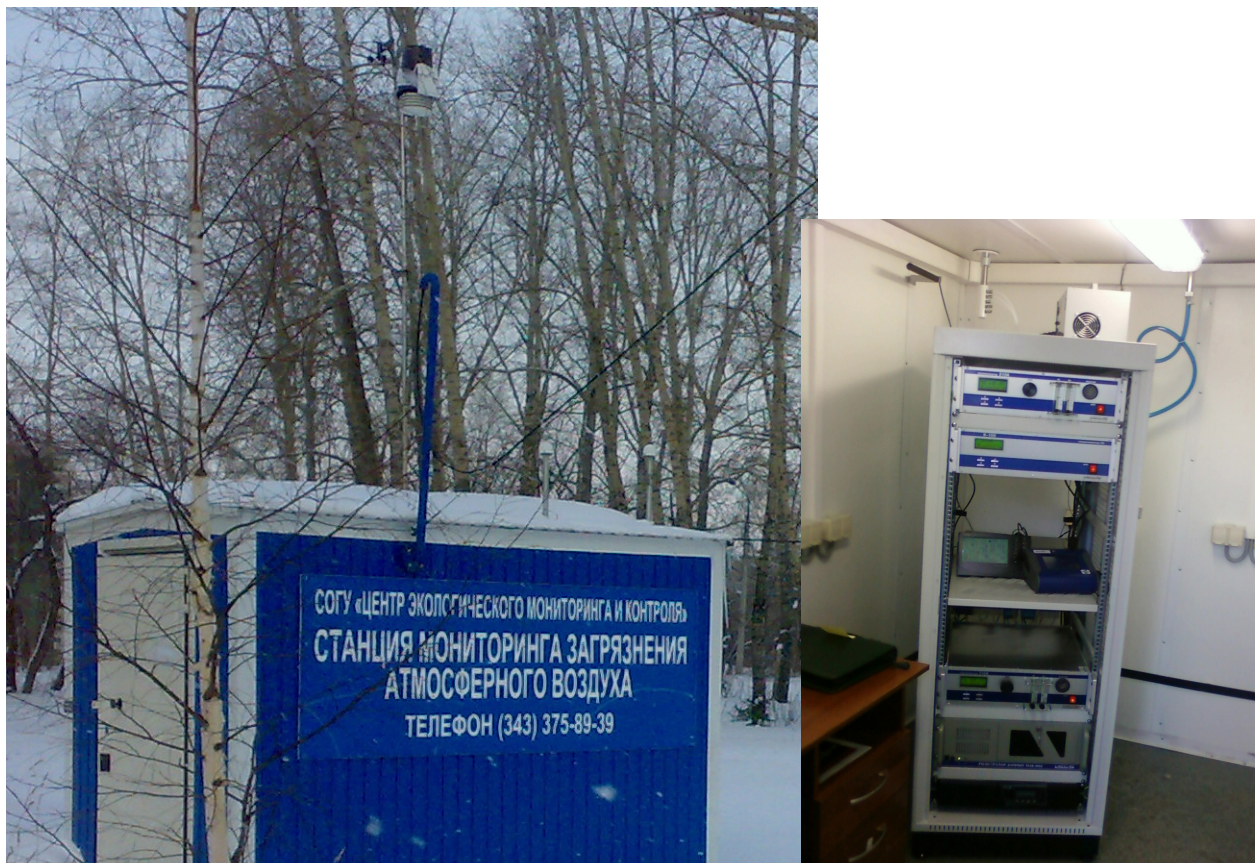
Рис. 6.4.1. Внешний вид и внутреннее оснащение автоматической станции контроля за загрязнением атмосферного воздуха
